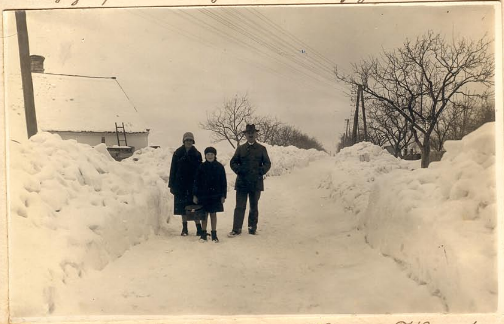
Laváta silnice k Hodonínu 3. března. Vlevo domček, dnes zbořený. V těch místech se stavi měšt. škola. -
